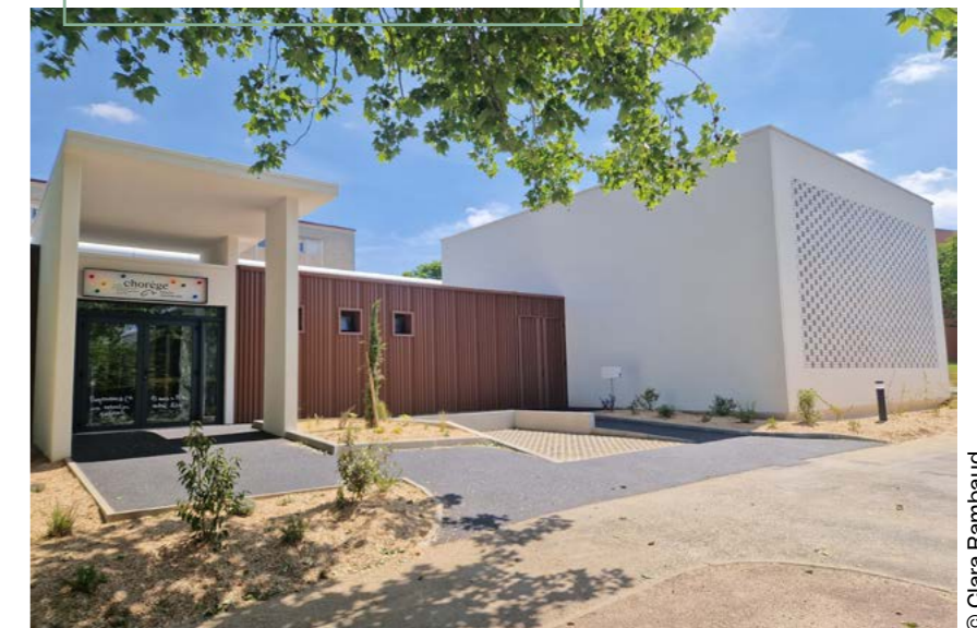
Le nouveau bâtiment du CDCN
